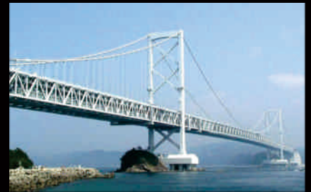
日本 本州四國聯絡橋 照明柱的塗裝 & 修補
