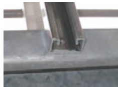
鍍鋅鋁鎂鋼板的切割端面修補
