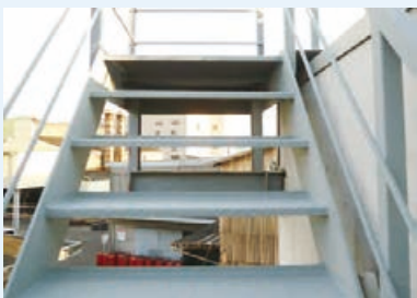
室外鋼筋樓梯
