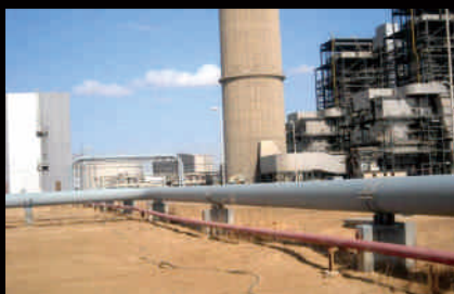
埃及 煤氣管道塗裝
