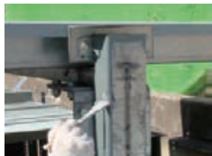
鍍鋅面上直接塗刷
