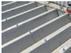
鋼板屋頂的螺栓部分加強修補
