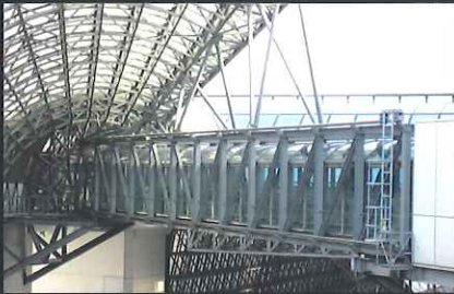
日本 JR京都站 空中走廊的全面塗裝
