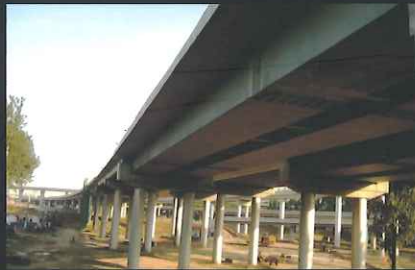
中國 北京機場南線公路
