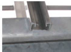
鍍鋅鋁鎂鋼板的切割端面修補
