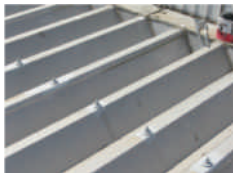
鋼板屋頂的螺栓部分加強修補
