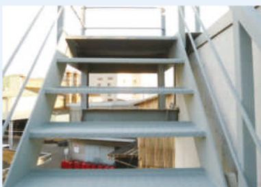
室外鋼筋樓梯
