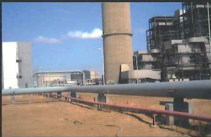
埃及 煤氣管道塗裝
