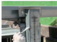
鍍鋅面上直接塗刷
